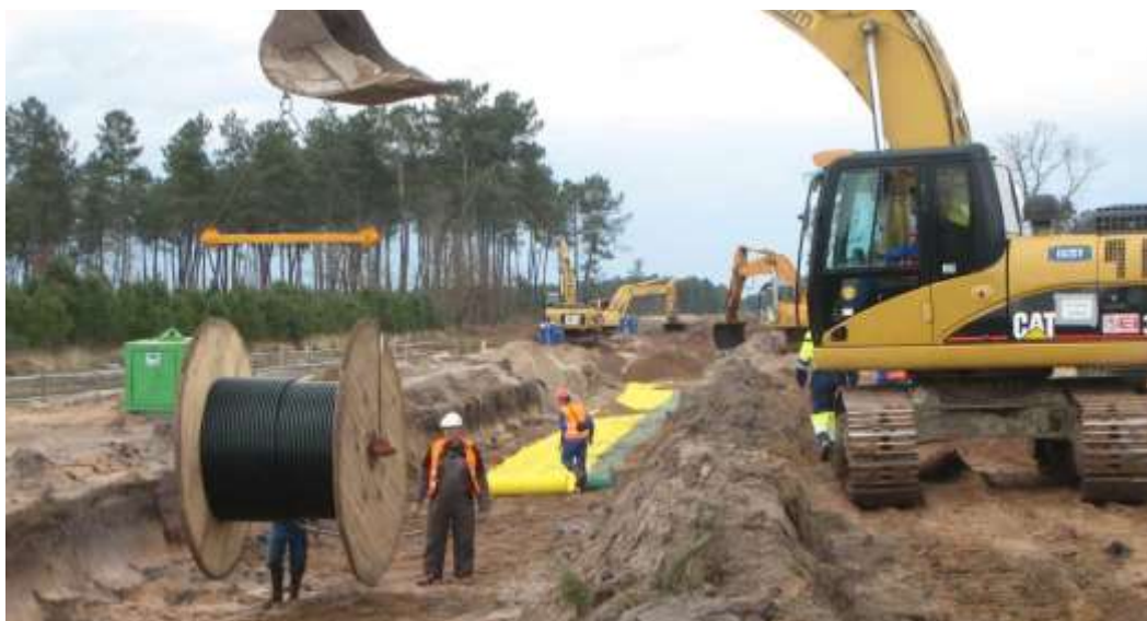
Mise en place du grillage jaune pour la signalisation et la protection de la canalisation
