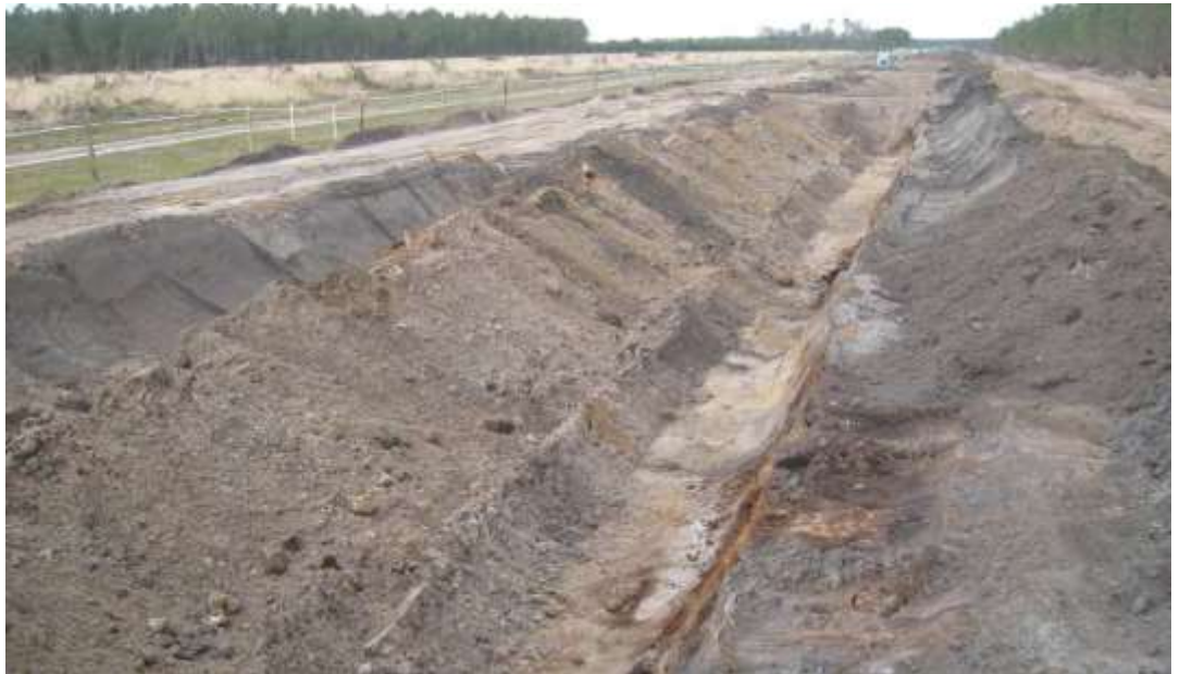
Fermeture de la tranchée
