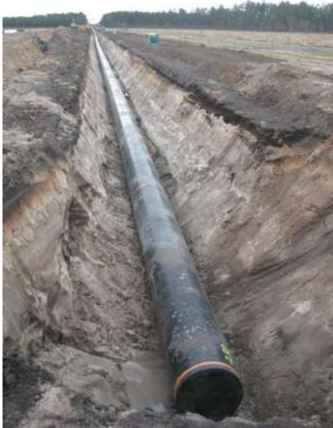
Installation de la canalisation à l'intérieur de la tranchée
