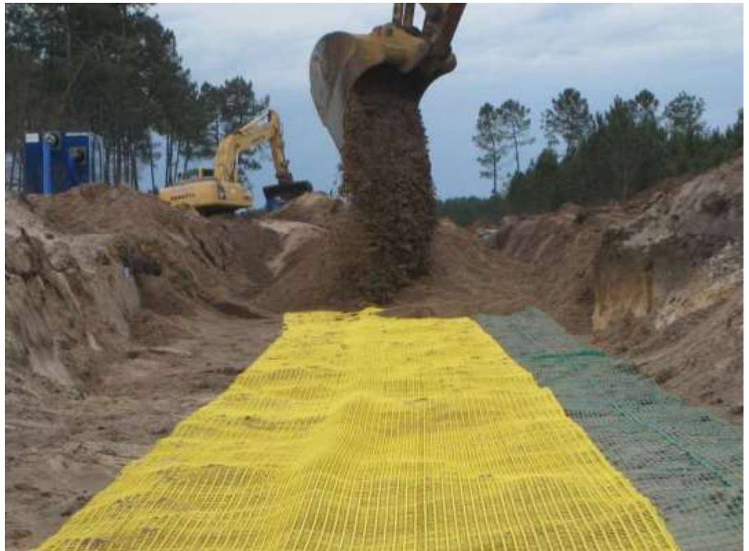
Remblaiement par-dessus le grillage.
