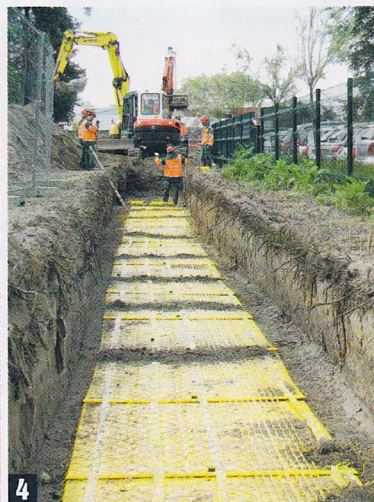
Chantier de protection de 500 m d'un gazoduc, à Mérignac (maître d'ouvrage et maître d'œuvre : TIGF ; maître d'œuvre délégué : Topod'Oc ; entreprise : Scam TP). Etapes de mise en œuvre : 1 Un sondage électromagnétique permet de vérifier que le niveau bas de la fouille est bien 40 cm au-dessus de la canalisation. 2 D'une masse comprise entre 25 et 39 kg (15 mm d'épaisseur), la dalle est portée manuellement depuis la palette jusqu'à son lieu de pose. 3 Mise en œuvre à la main, elle est simplement clipsée à la dalle précédente. 4 La simplicité du système autorise des cadences importantes.
