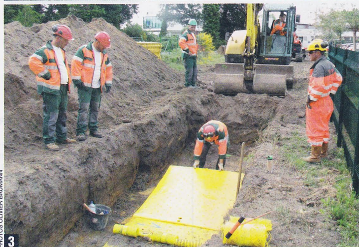
Chantier de protection de 500 m d'un gazoduc, à Mérignac (maître d'ouvrage et maître d'œuvre : TIGF ; maître d'œuvre délégué : Topod'Oc ; entreprise : Scam TP). Etapes de mise en œuvre : 1 Un sondage électromagnétique permet de vérifier que le niveau bas de la fouille est bien 40 cm au-dessus de la canalisation. 2 D'une masse comprise entre 25 et 39 kg (15 mm d'épaisseur), la dalle est portée manuellement depuis la palette jusqu'à son lieu de pose. 3 Mise en œuvre à la main, elle est simplement clipsée à la dalle précédente. 4 La simplicité du système autorise des cadences importantes.
